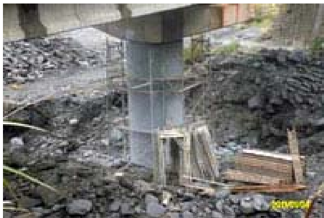
實際補強工程
