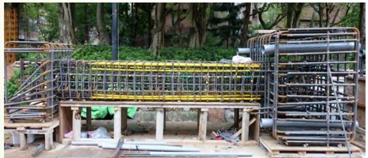
(g)先進自復位橋柱組裝照片
