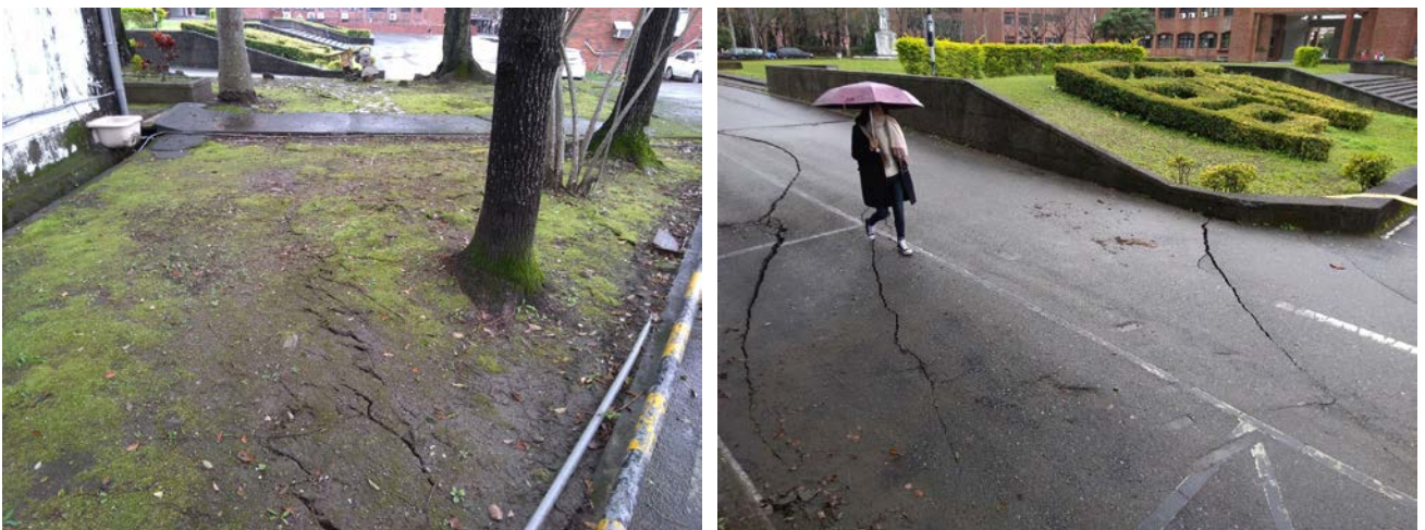
圖 2-1-1-13、地表破裂轉進入校園，於「花師」花圃附近地形崖造成一系列雁行排列伸張裂隙。左圖向西南拍攝，右圖向南拍攝。劉彥求攝。
