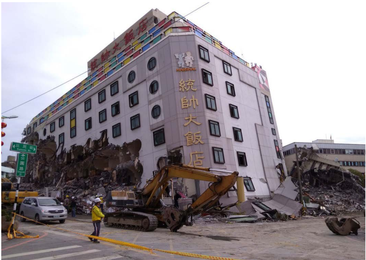
圖 2-3-4、統帥大飯店 2 樓以下皆壓毀，現場進行拆除作業。莊釗鳴攝。
