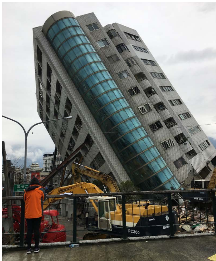
圖 2-3-2、雲門翠堤大樓傾倒，救災單位以鋼樑緊急支撐。陳思婷攝。
