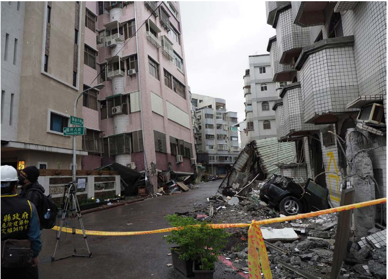
圖 2-2-10、美崙溪西側堤內部份房屋底層塌陷或建物傾斜，調查當時已即將進行拆除。莊釗鳴攝。
