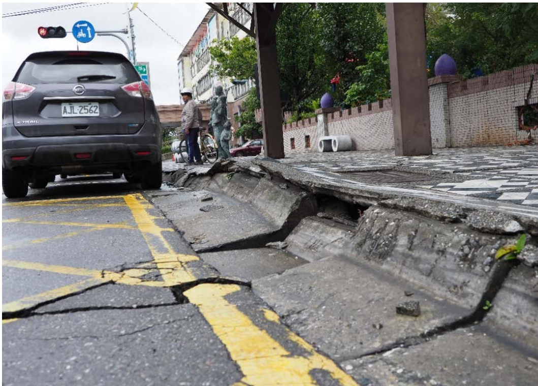
圖 2-1-2-13、中正路破裂。裂隙可分為 2 組，一組平行中正路走向 N60^{\circ}E ，另一組為走向為 N26^{\circ}W ，朝東北拍攝。莊釗鳴攝。
