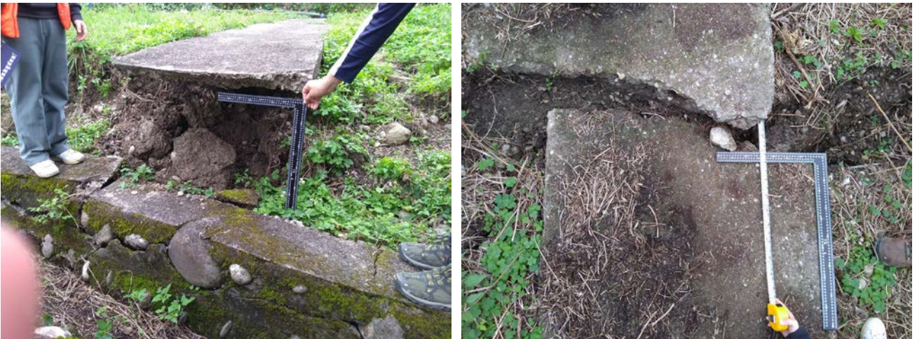
圖 2-1-1-9、華西路西側崖坡中段，一處人工結構物受錯動，東華大學顏君毅教授等團隊測量變形量，向北拍攝。劉彥求攝。
