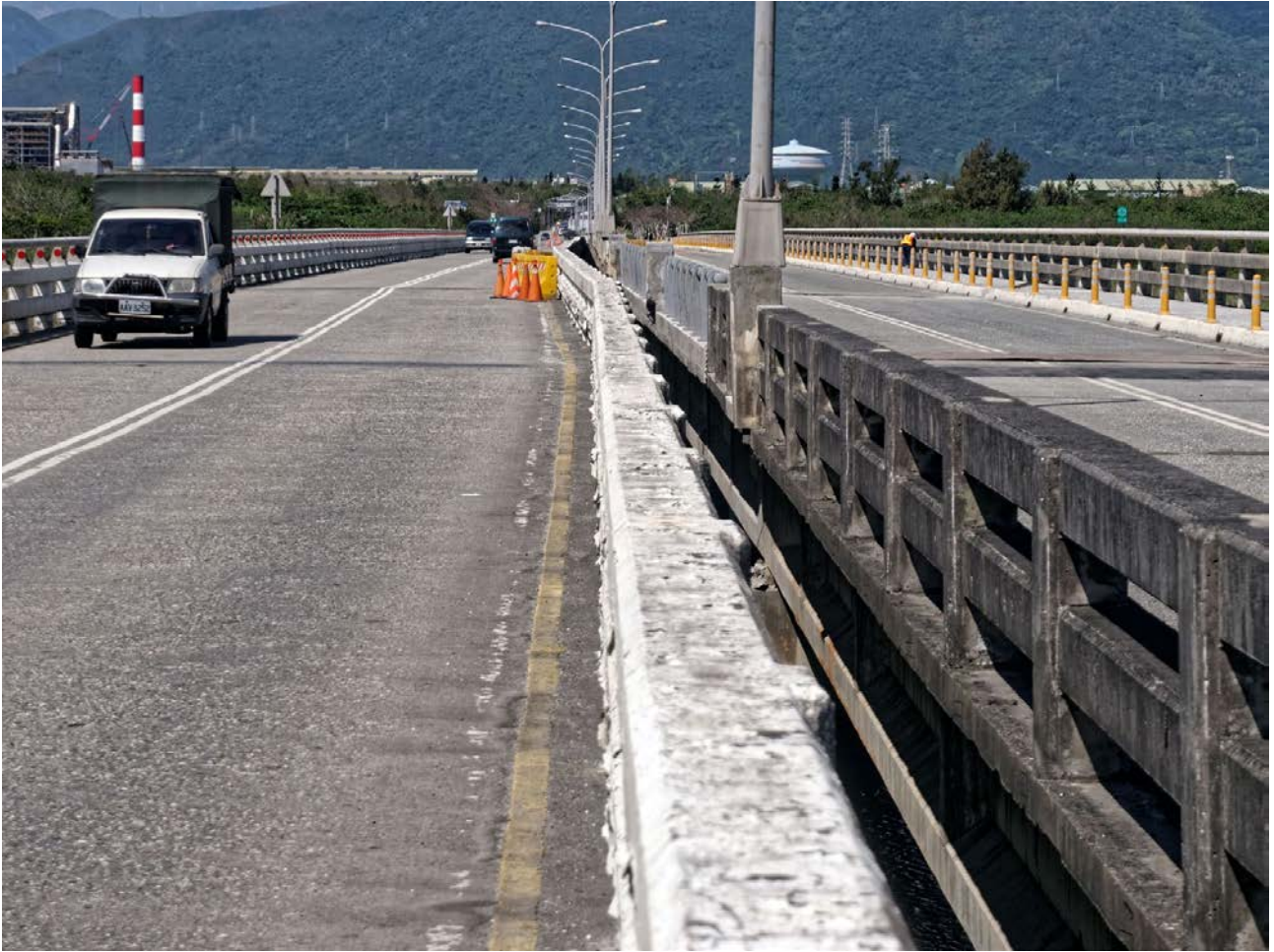
圖 2-1-3-2、花蓮大橋 P9、P10 橋墩左移形式錯動約 70 公分。由西向東拍攝，劉彥求攝。
