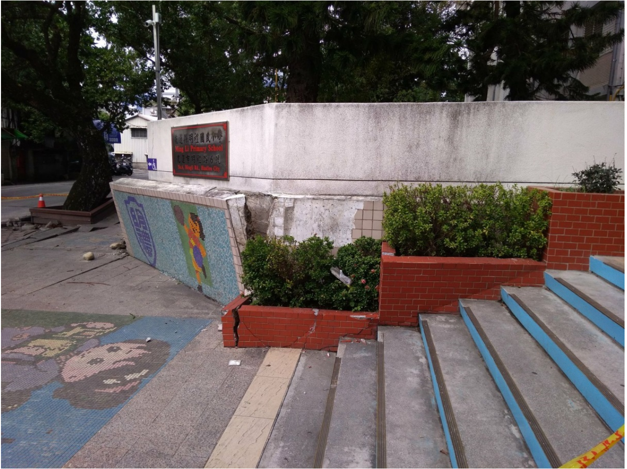
圖 2-1-2-6、明禮國小正門北側、圍牆與人行道遭推擠向外突出與拱起。劉彥求攝。
