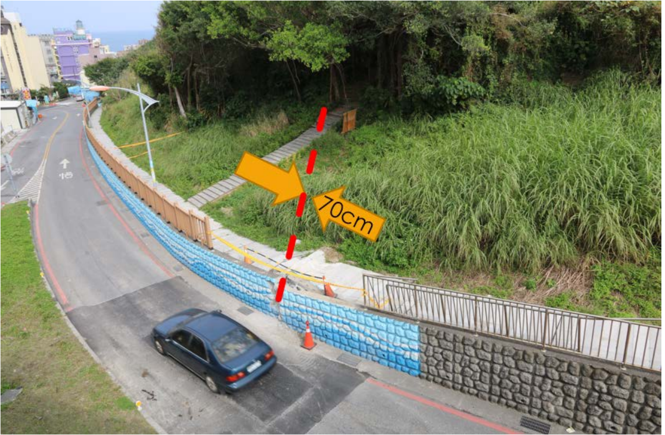
圖 2-1-1-8、七星潭大橋南側步道有明顯的左移現象，錯移位置與地形崖相符。陳柏村攝。
