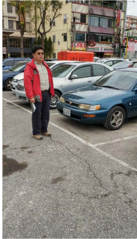
圖 2-1-2-19、三民停車場後方圍牆因地震破損，破損點下方有一條裂隙以 N40^{\circ}-50^{\circ}E 方向朝南延伸。黃志遠攝。
