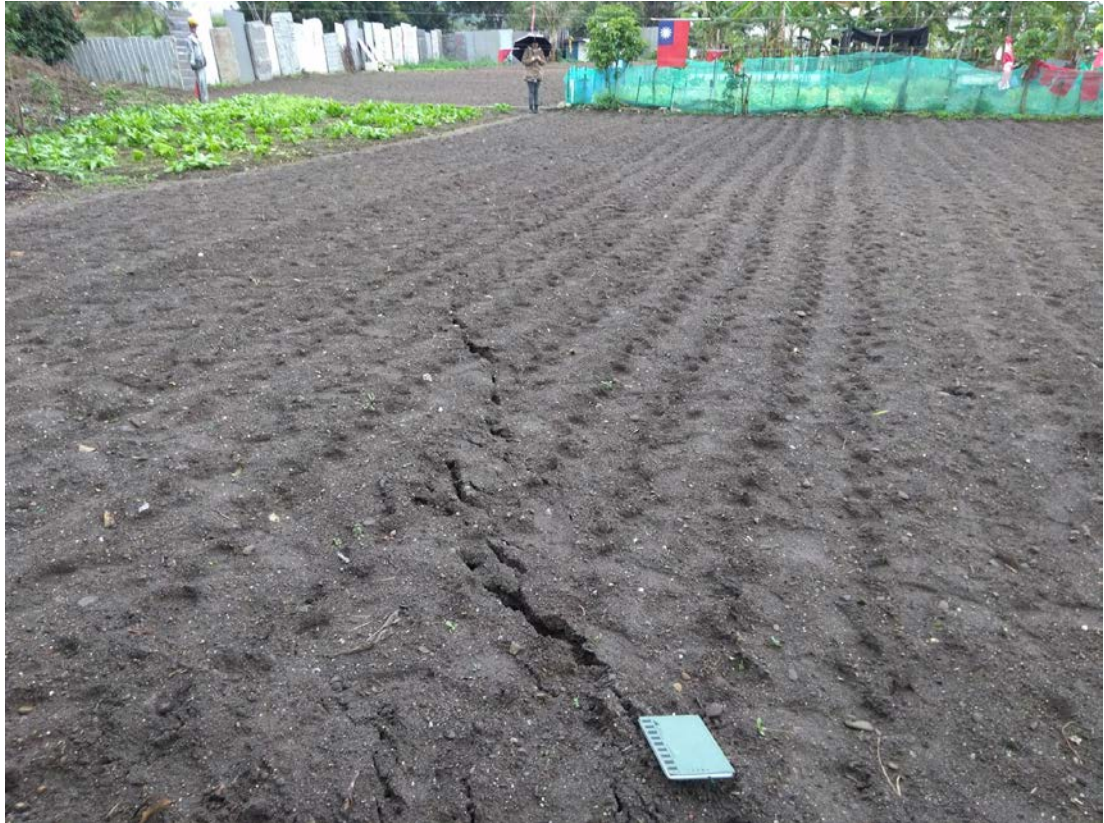
圖 2-1-1-22、地表破裂向南繼續錯動水泥溝渠、呈雁行排列裂隙穿過嘉南路東側田地與民宅，向西南拍攝。劉彥求攝。
