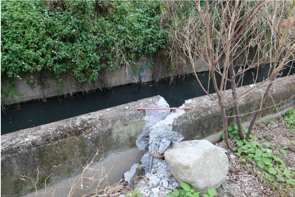
圖 2-1-1-24、壓縮斷裂的渠道與彎曲的鋼筋，鋼筋之壓縮量大於 30 公分。陳柏村攝。
