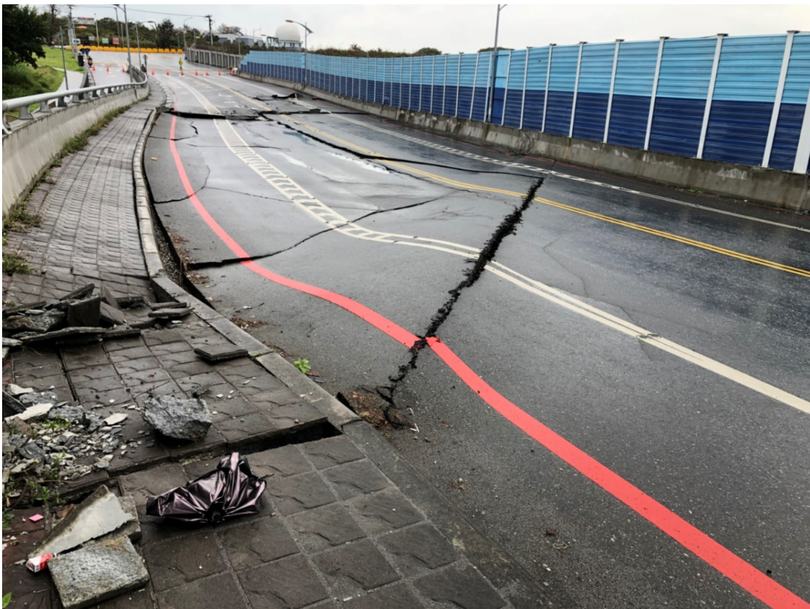
圖 2-1-1-7、七星潭大橋橋面及周圍多為結構物控制的裂痕。貫穿橋面的裂紋走向為南北向至北東 30 度，主要柏油路面與底層分離，拆層拱起，最高高度差約 50 公分。呂貞怡攝。
