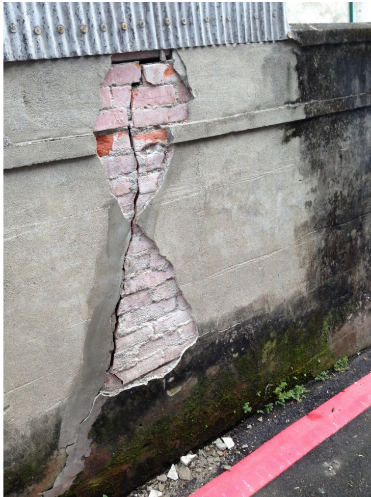
圖 2-1-2-4、美崙溪河堤旁明禮路內部分民宅及停車場圍牆及地面受損。黃志遠攝。
