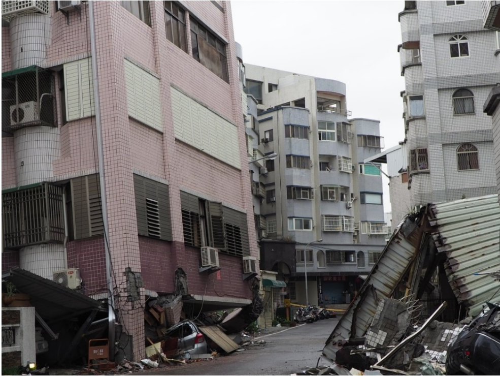
圖 2-3-1、吾居吾宿大樓（左）及白金雙星大樓（右）之倒塌。莊釗鳴攝。
