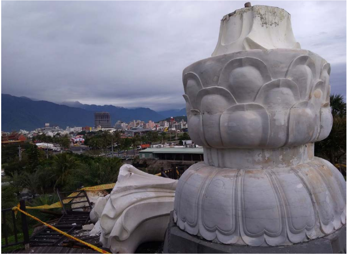
圖 2-1-2-31、南濱公園內觀音像受到強震影響從接縫處斷裂。朝 N40°W 方向倒向花蓮市。劉彥求攝。
