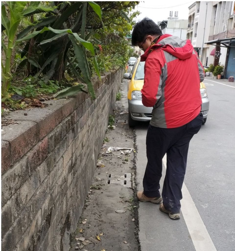
圖 2-2-7、美崙溪堤旁水溝也可見小規模單點噴砂現象。黃志遠攝。
