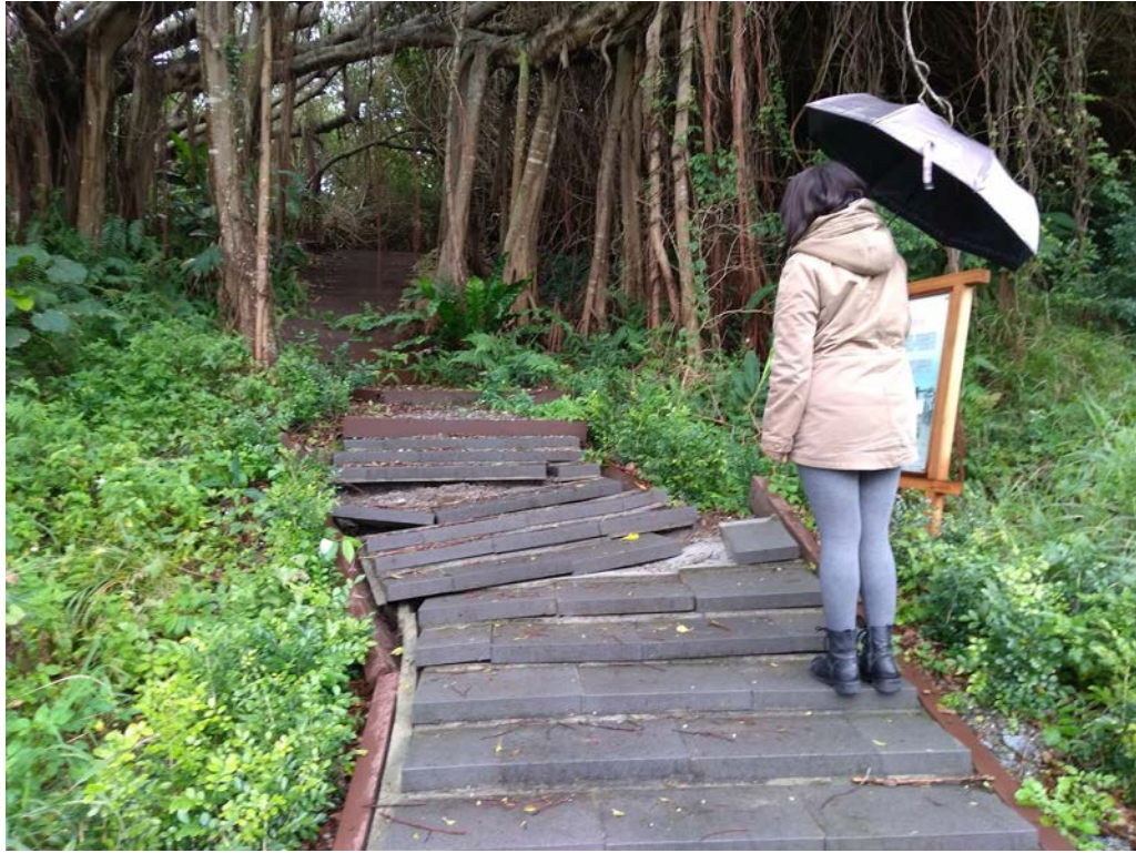
圖 2-1-1-6、七星山西側步道之破壞。步道遭到左移錯動約 70 公分，向東拍攝。劉彥求攝。
