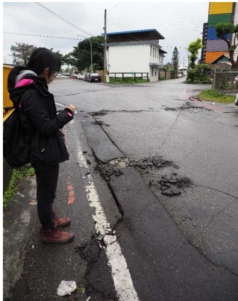
圖 2-1-2-24、福建街與光復街口破裂。有一條平行福建街的 N60^{\circ}E 裂隙，以及 N8^{\circ}E 至 N10^{\circ}E 裂隙，於光復街朝東南拍攝。莊釗鳴攝。
