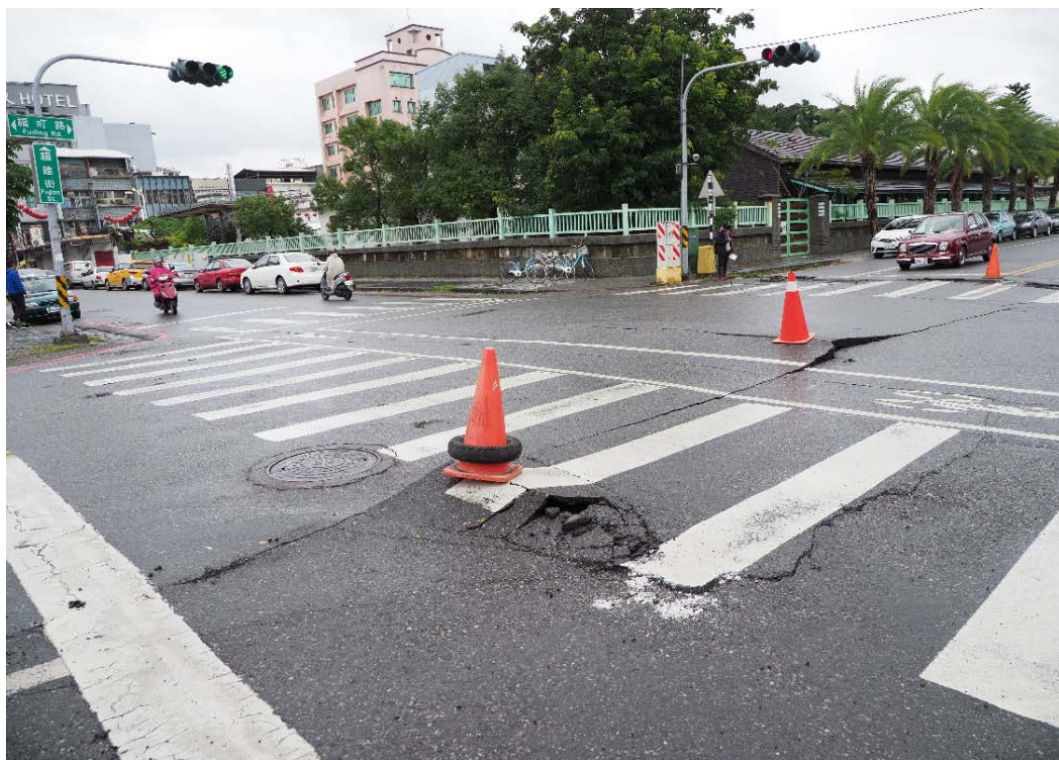
圖 2-1-2-25、福建街與福町街口破裂。方位主要是 N52^{\circ}\sim 56^{\circ}E 與 N46^{\circ}W ，於福町街朝東拍攝。莊釗鳴攝。
