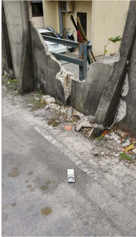
圖 2-1-2-19、三民停車場後方圍牆因地震破損，破損點下方有一條裂隙以 N40^{\circ}-50^{\circ}E 方向朝南延伸。黃志遠攝。
