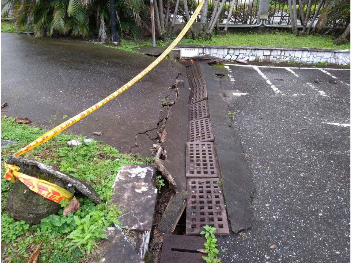
圖 2-1-1-18、地表破裂循側門附近圍牆向 S20°W 穿出校園，此處過去亦為斷層潛移位置之一，向南拍攝。劉彥求攝。
