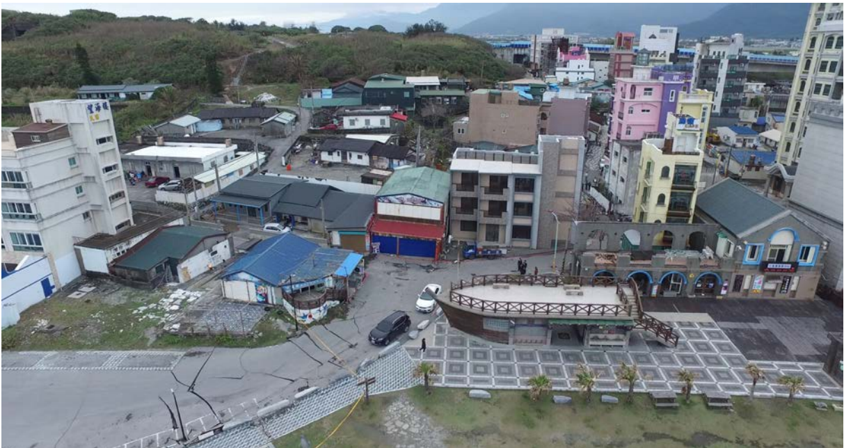
圖 2-1-1-4、向南俯瞰七星潭與七星山周邊聚落內地表破裂，東側山體向北東移動，造成周邊民宅、道路與停車場遭推擠拱起，位於山坡上建物與道路等則產生伸張破裂。李柏村攝。
