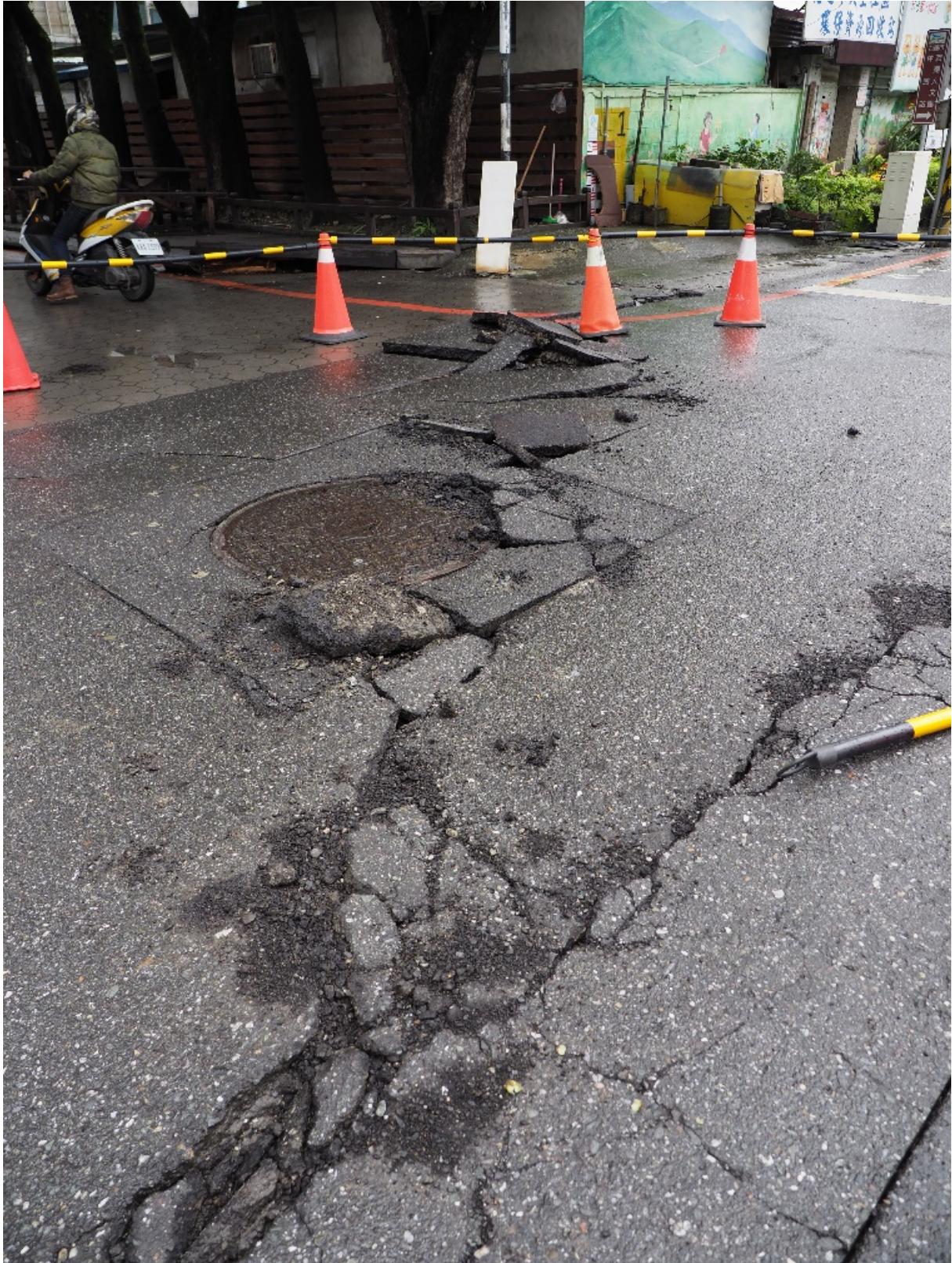
圖 2-1-2-14、三民街與公正街口破裂。裂隙走向為 N70^{\circ}W ，路面柏油拱起約 25 公分，朝西拍攝。莊釗鳴攝。
