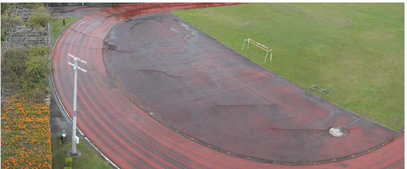
圖 2-1-1-15、地表破裂循轉向 S10^{\circ}-15^{\circ}W ，在 PU 跑道西側形成左移型式的雁行排列伸張破裂，向東北俯攝。劉彥求攝。
