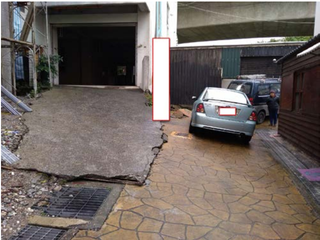
圖 2-1-1-5、七星山周邊地表破裂。尤以七星街周邊民宅災損最為嚴重，部分房屋傾斜及牆壁、梁柱與地板破損，1951 年地表破裂也曾在此造成重大災損。劉彥求攝。
