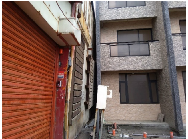
圖 2-1-1-5、七星山周邊地表破裂。尤以七星街周邊民宅災損最為嚴重，部分房屋傾斜及牆壁、梁柱與地板破損，1951 年地表破裂也曾在此造成重大災損。劉彥求攝。
