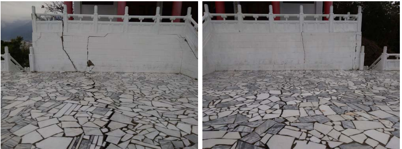
圖 2-1-1-29、忠烈祠大殿與廣場地表破裂，地表破裂造成殿體與廣場東側略為抬升，以及西側略為傾斜。左圖向北拍攝，右圖向南拍攝。劉彥求攝。
