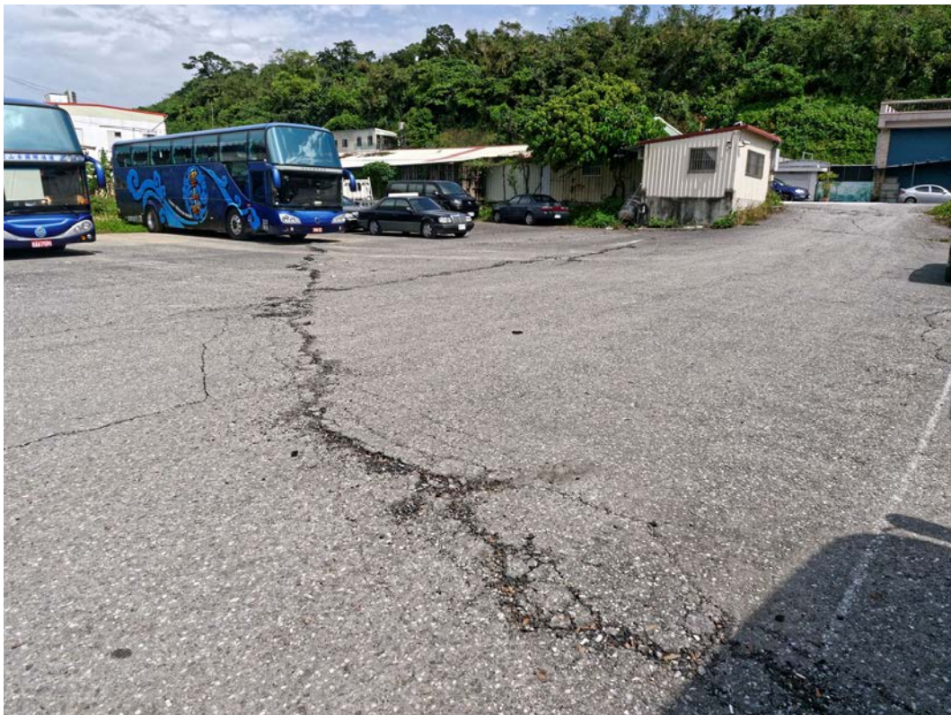
圖 2-1-1-33、破裂向南延伸至停車場內，於小崖上、鐵皮屋內發育出至少 3 條破裂，向東北拍攝。劉彥求攝。
