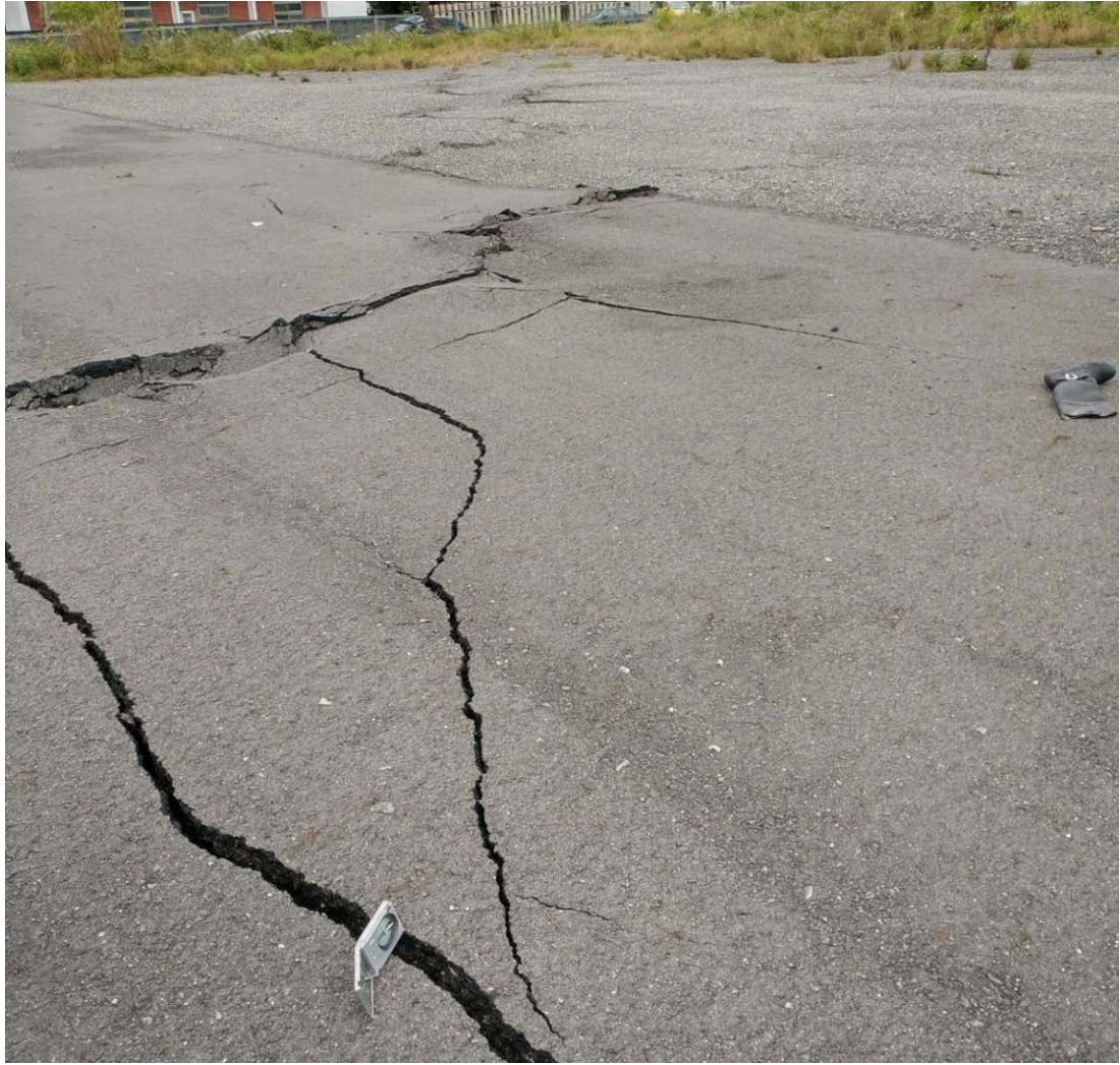
圖 2-1-2-27、東大門樂園旁空地發現一組連續性良好，呈現雁行排列地表破裂，整體以 N5^{\circ}E 走向向兩側延伸，其最大隆升量約 15 公分，最大左移量約 10 公分。黃志遠攝。
