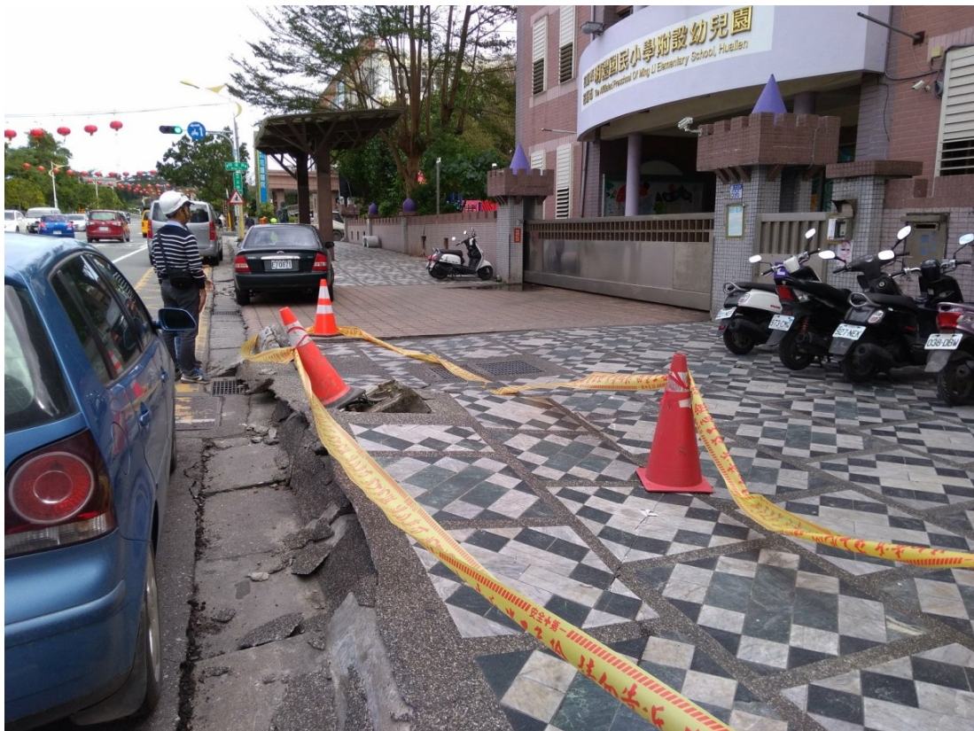
圖 2-1-2-8、中正路明禮國小附設幼兒園前人行道與馬路產生裂隙與拱起，此處裂隙與 1951 年地震地表破裂位置相近，並具左移錯動。劉彥求攝。
