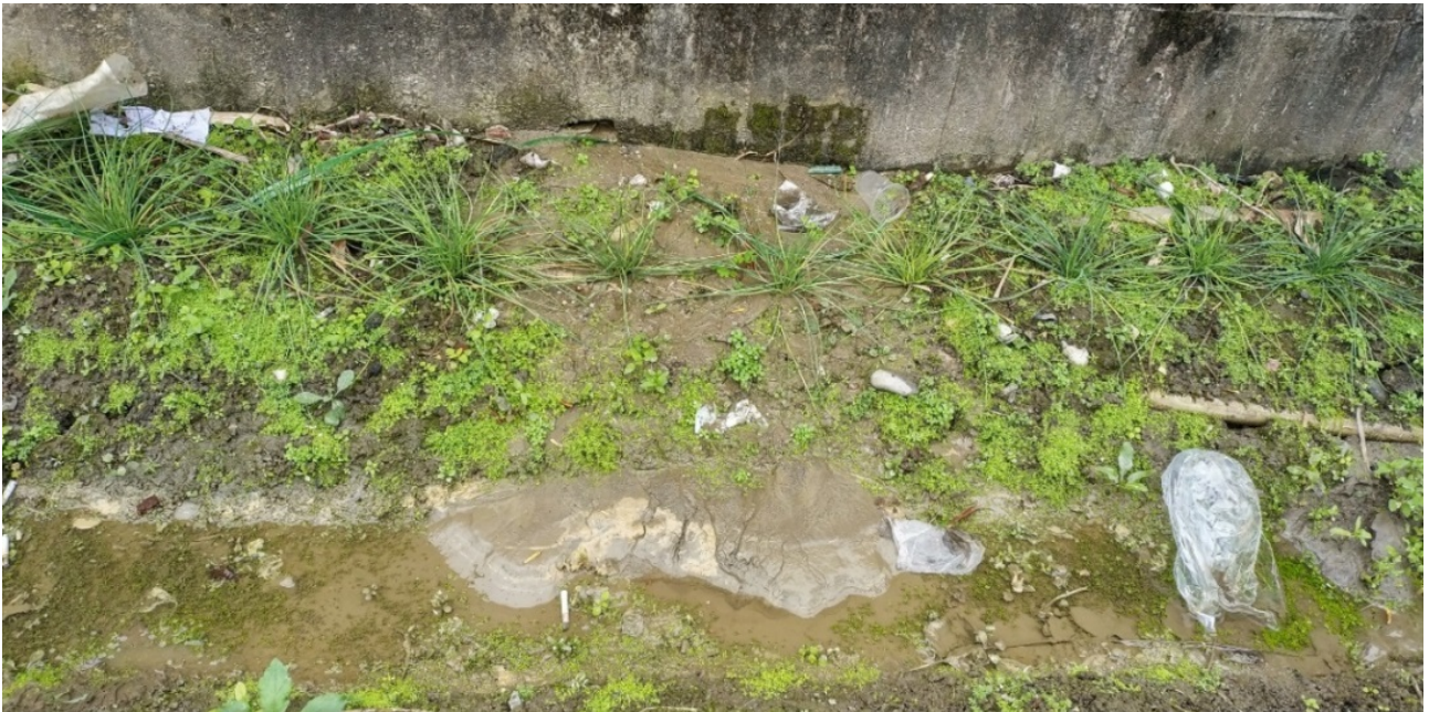
圖 2-2-9、國盛八街河堤下農田與擋土牆間隙擠出小規模噴砂現象。黃志遠攝。
